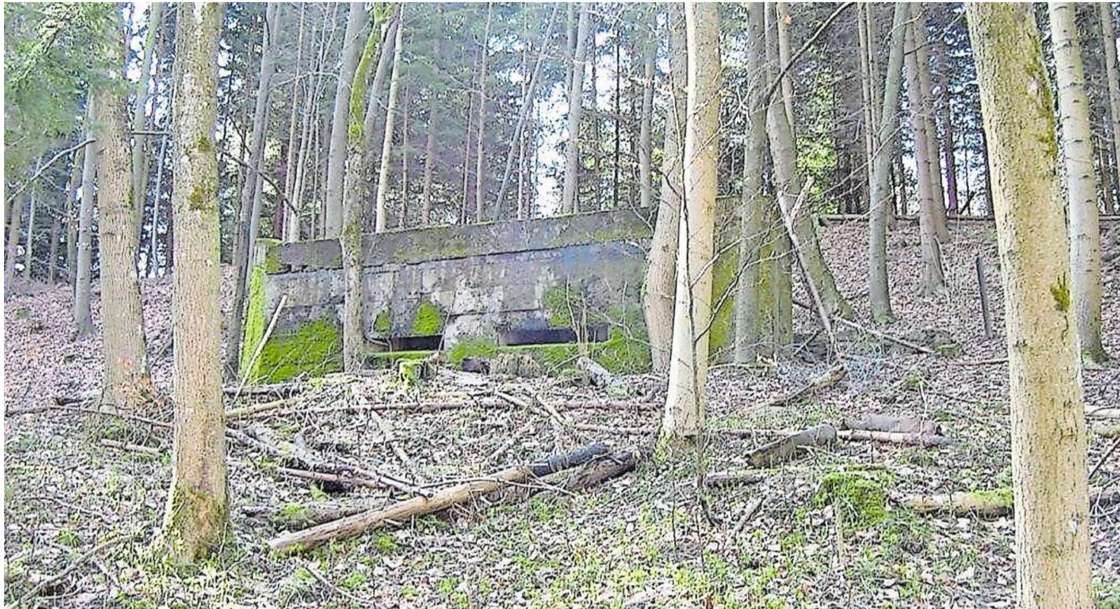
Nur ein Rückzug für Schützen – oder handelt es sich bei diesem Bunker um eine grössere Anlage im Üetliberg-Wald?
